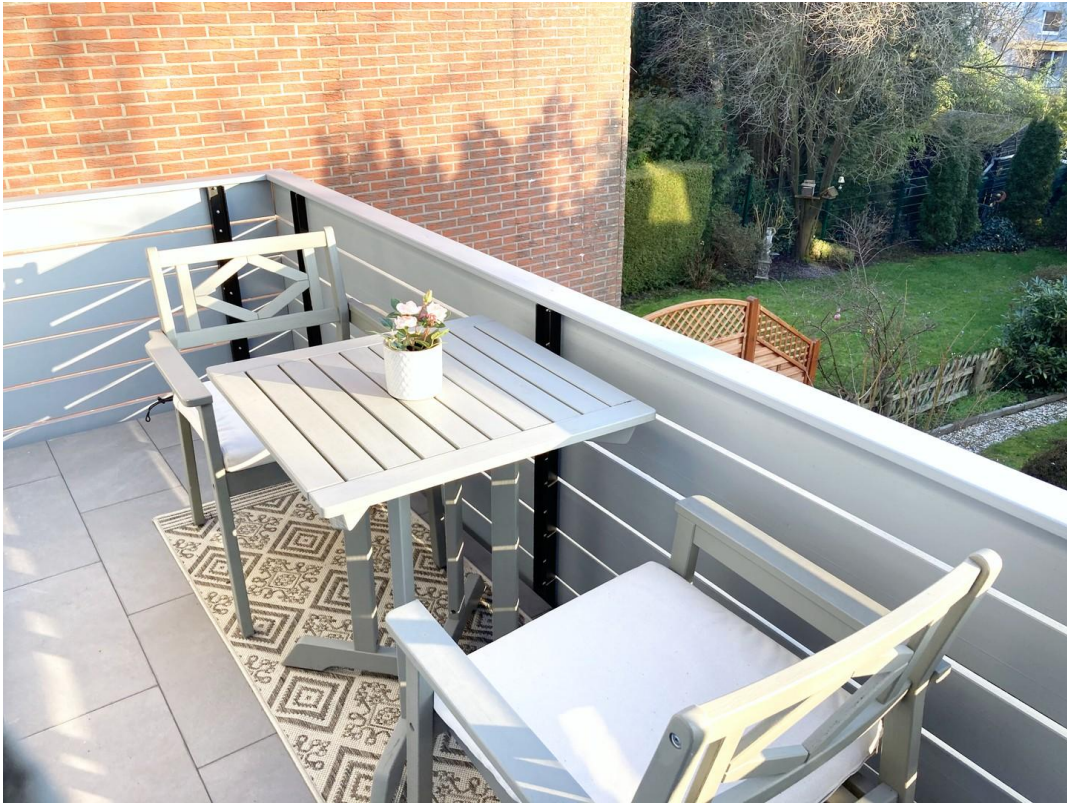
Sanierter Balkon Dachgeschoss
